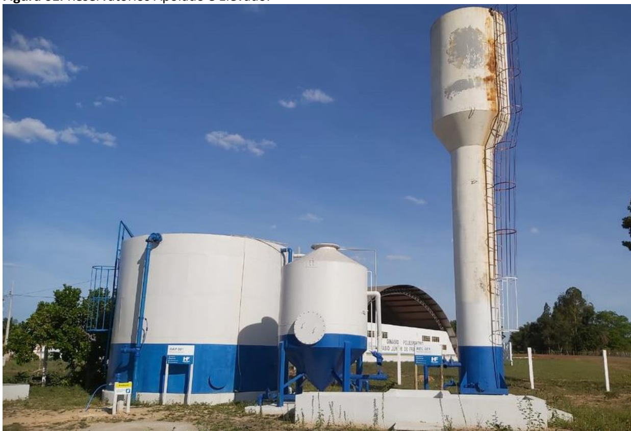
Figura 61. Reservatórios Apoiado e Elevado.
