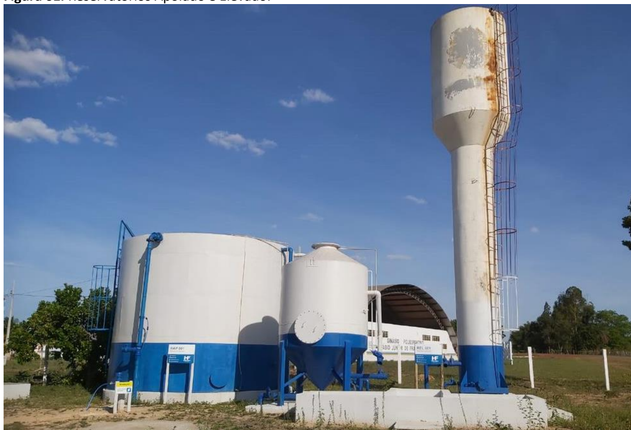
Figura 61. Reservatórios Apoiado e Elevado.
