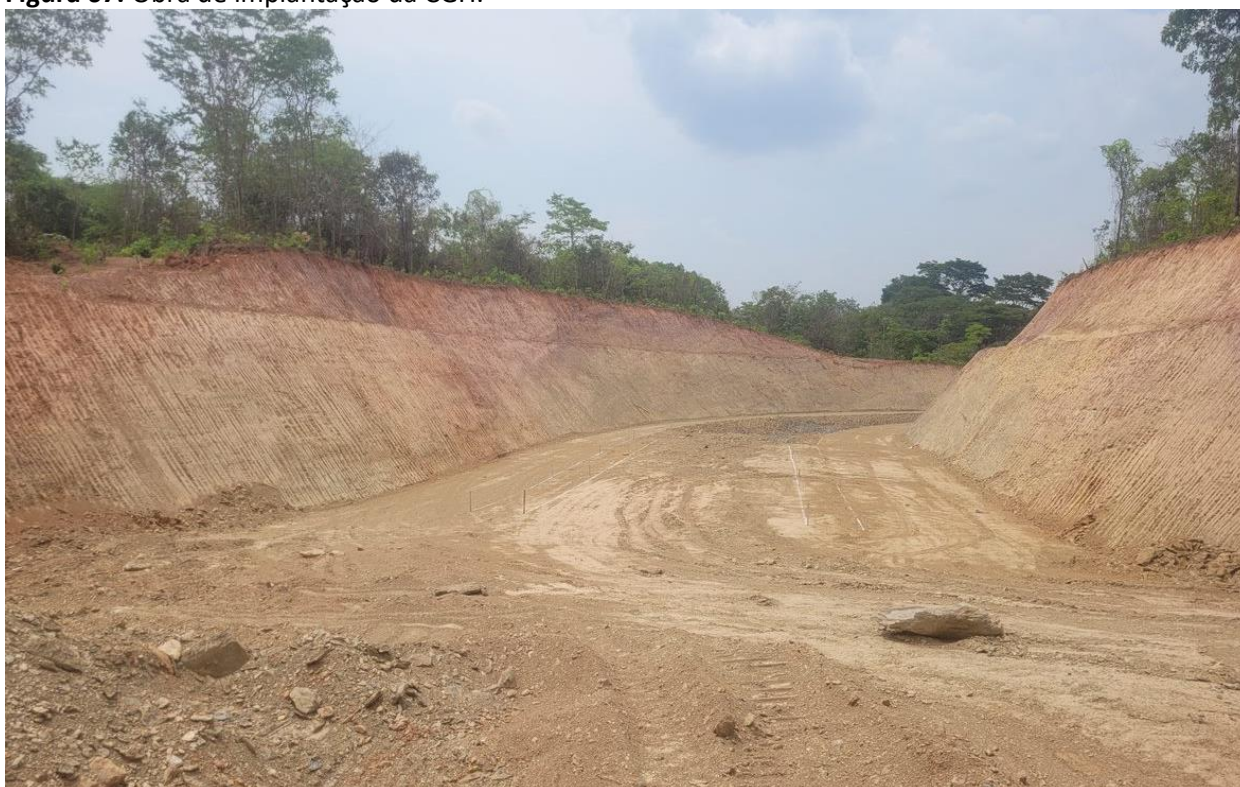
Figura 67. Obra de implantação da CGH.
