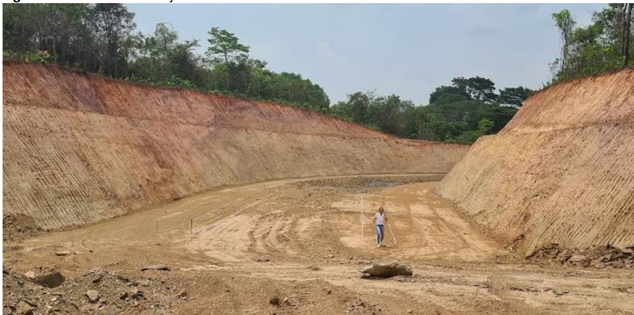
Figura 29. Obra de Construção da CGH
