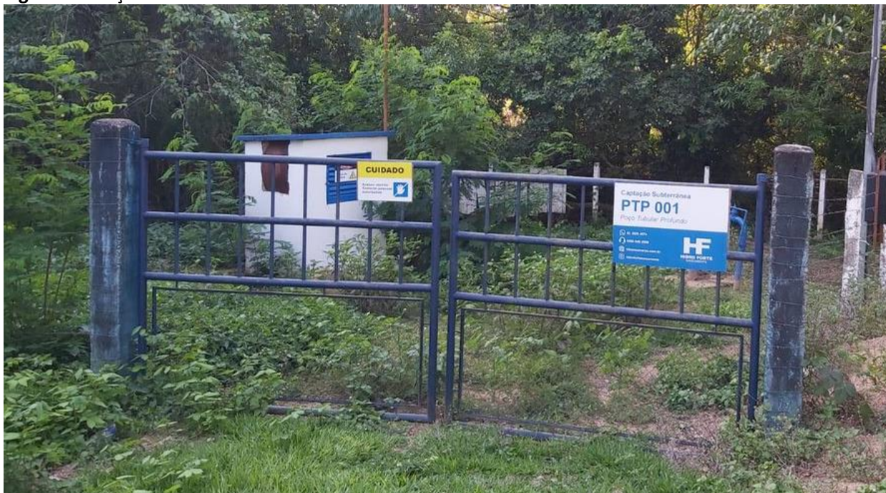
Figura 57. Poço Tubular Profundo 001.
