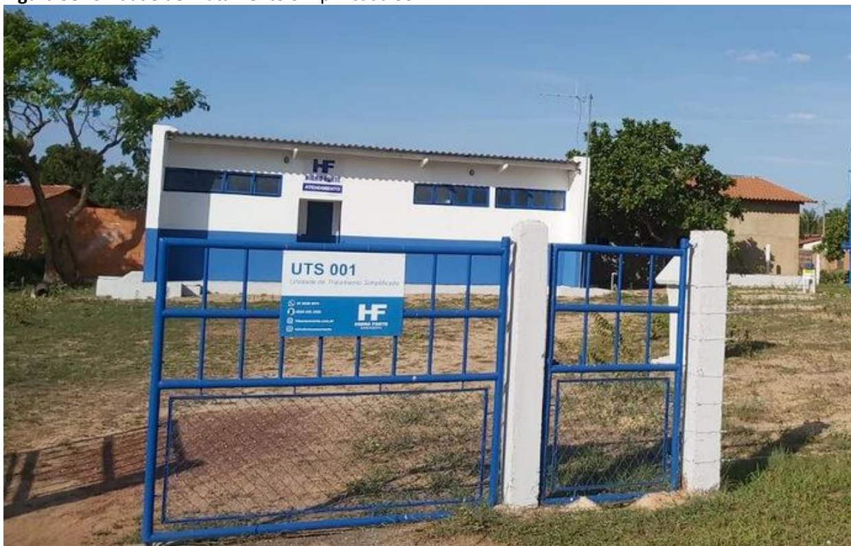
Figura 58. Unidade de Tratamento Simplificada 001.
