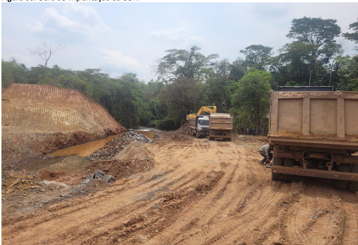
Figura 66. Obra de implantação da CGH.
